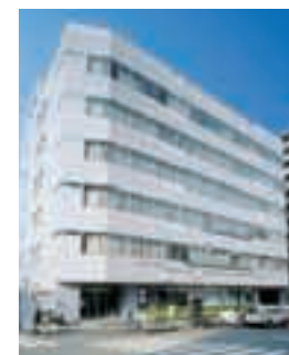
I-13 JAL TRAVEL BUILDING JALトラベルビル
