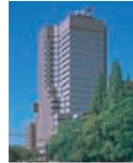
Ⅲ-11 NHK HIROSHIMA BROADCASTING CENTER BUILDING NHK広島放送センタービル
