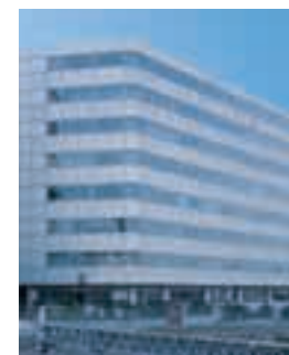
I-21 OTSUKA HIGASHI-IKEBUKURO BUILDING 大塚東池袋ビルディング
