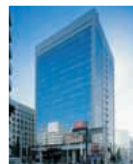
NAGOYA HIROKOJI BUILDING III-5 名古屋広小路ビルディング
