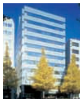
SENDAI HONCHO HONMA BUILDING III-1 仙台本町ホンマビルディング
